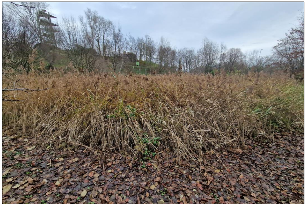
Abbildung 13: Blick auf Versickerungsmulde in westliche Richtung
